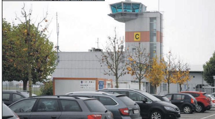
La tour de contrôle actuelle en fonction jusqu'à l'année prochaine
