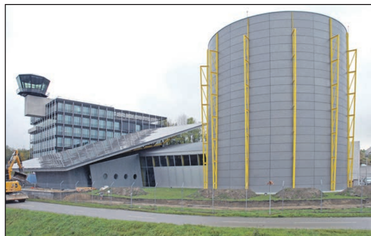
Le nouveau bâtiment en phase de finition
